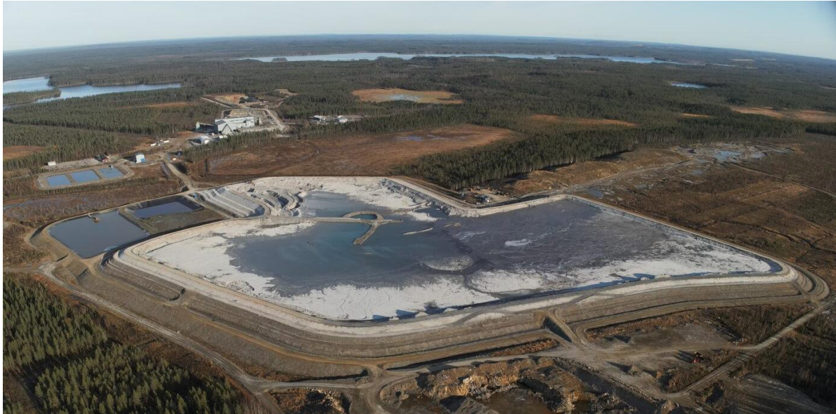
Kuva 12-1. Rikastushiekka- ja allasalue.
